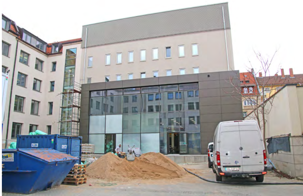
Der neue Bauteil F beinhaltet neben der Cafeteria auch mehrere Multifunktionsräume. Der Innenausbau ist abgeschlossen, die Gestaltung des Innenhofs samt Terrasse für die Cafeteria folgt.
