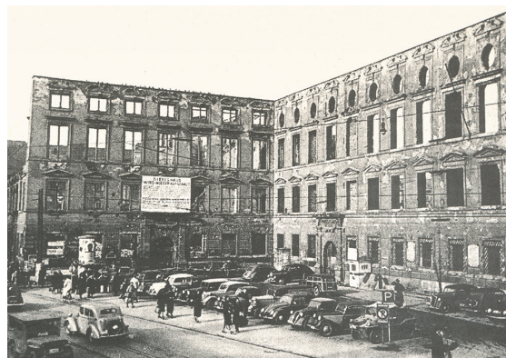
Vom Krieg zerstört: Nach Fliegerangriffen im Jahr 1944 blieb von der Alten Akademie nur noch die Fassade stehen.
